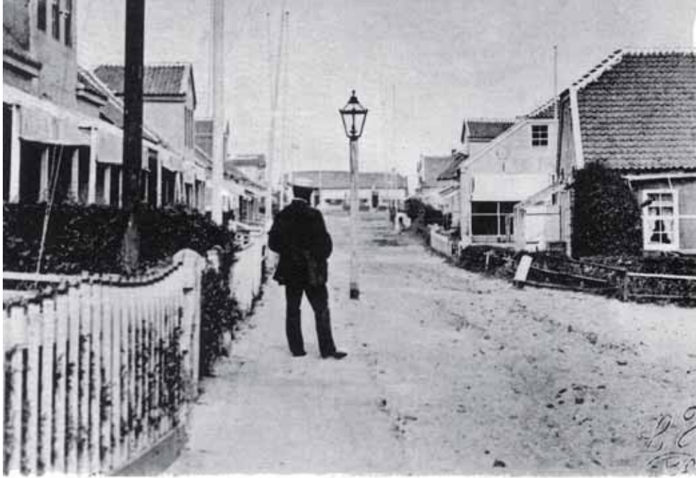
Die Luisenstraße, zwar schon mit Straßenbeleuchtung aber noch ungepflastert (oben); Foto unten: immer an der Spitze des Fortschrittes — viel eher als selbst Großstädte legte sich Nordsee im vergangenen Jahrhundert ein eigenes Gaswerk zu. Heute wird die Insel von einer Erdgaspipeline versorgt, und auf dem einstigen Gaswerksgelände entstehen moderne Wohnblöcke
