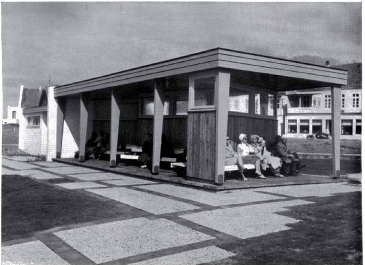
Die neue Weststrand-Schutzhalle
