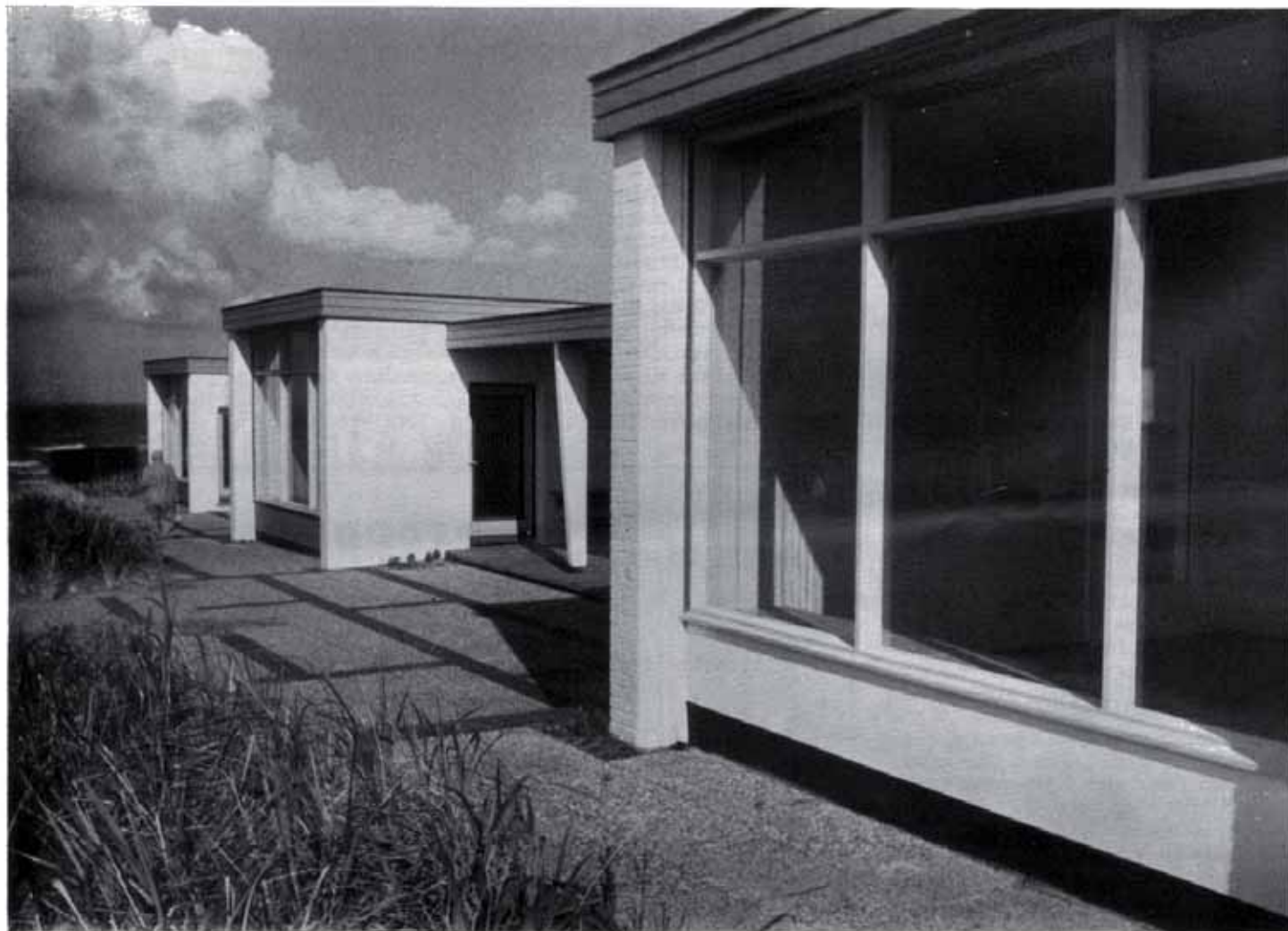
Die vor dem Nordstrand neu entstandenen Schutz- und Badehallen
