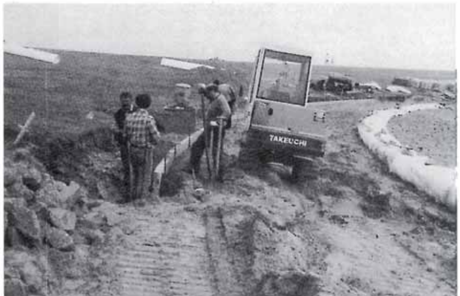
Erneuerung und Instandhaltung der Inseldeiche
