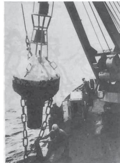
In der Accumer Ee wird eine vertriebene Spierentonne auf ihre Sollposition gelegt und die Position einer Wracktonne muß kontrolliert werden.
