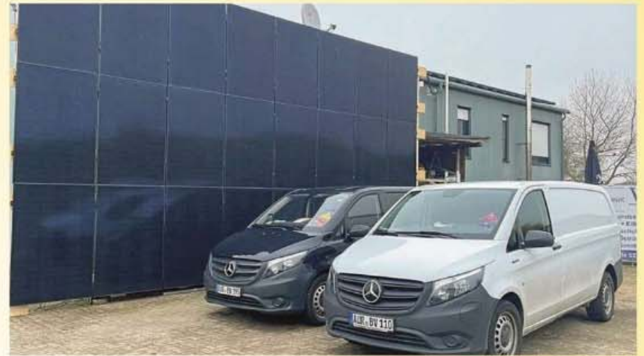
Auch im eigenen Haus wird bereits seit Jahren auf solare Technologien gesetzt. Fotos: privat
