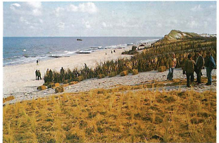
Die im Sommer 1981 aufgefahrene künstliche Randdüne an der Kugelbake Norderney wird mit natürlichen Mitteln begrünt – Buschzäune brechen den Wind, ausgebreitete Grasmahd sichert die Oberfläche und wirkt als Mulchschicht, Strandhafersetzlinge werden gepflanzt und breiten sich aus.
