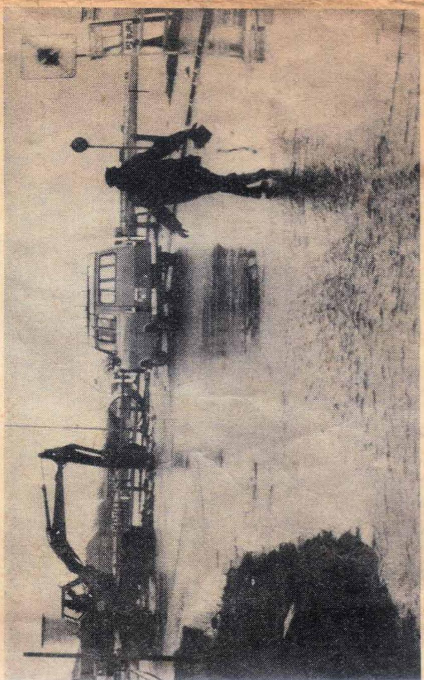
Die weitere Maßnahme zur Ableitung des auf das Transformatorhaus andrückenden Seewassers war der Durchstich der Hafensstraße, wodurch das Wasser in den dort befindlichen Entwässerungsgraben und somit in tieferes Gelände abfließen konnte.
