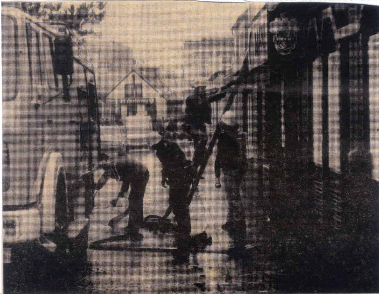
Nach einem ersten Löschangriff von innen wird ein weiterer Löscheininsatz über das Dach durchgeführt.
