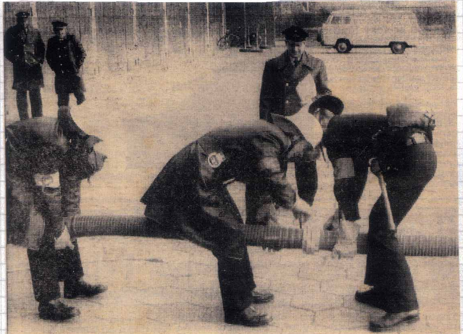
Übung und sichere Handgriffe erfordert das rasche Verbinden der Schlauchkupplungen.
