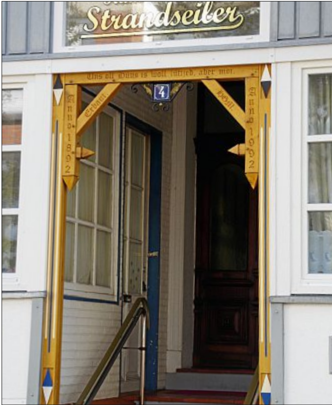
In diesem Frühjahr fertigte der junge Zimmermannsgeselle Hajo Eberhardt (Enkel von Bonno Eberhardt und Neffe von Rosemarie Eberhardt) aus Eiche diesen Türstock am Haus Strandseiler, Benekestraße 4, mit den Geschichtszahlen des Hauses. Jan Holtkamp von der Firma Stürenburg fertigte die Stieler an. Die „Salmiakpastillen“ sind eine Inseltradition an Ost- und Nordsee. Weiß-Schwarz oben und Blau-Weiß unten sollen die Norderneyer Farben symbolisieren.
