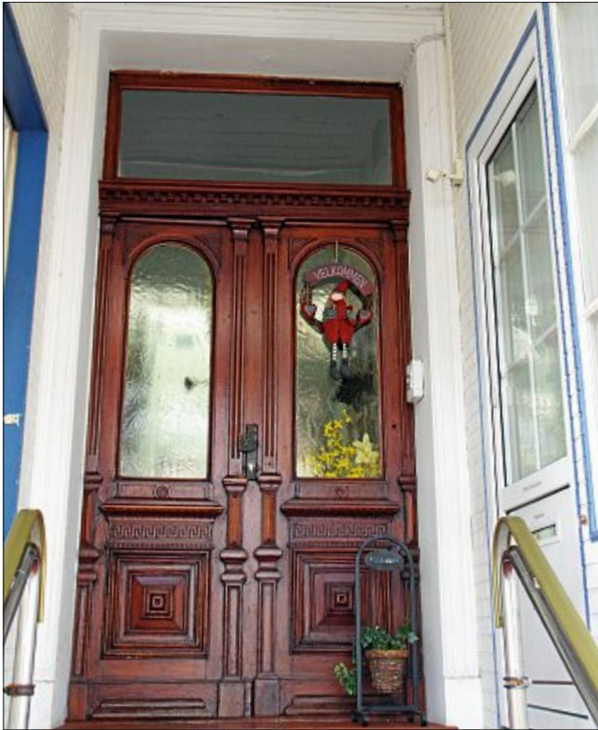
Vom Türstock (links) gelangt man zur ältesten Haustür der Benekestraße. Die Holztür zum Haus Nummer 4 fertigte 1892 die Tischlerei Hoppe & Jürgens in ihrer Werkstatt in der Josefstraße in reiner Handarbeit an. Heute, immerhin 125 Jahre später, geben durch die Tür immer noch Menschen ein und aus. Das alte Türschloss ist zusätzlich mit einem Zylinderschloss versehen. Wegen des Gewichtes müssen die Türhänger jedes Jahr gefettet werden.
