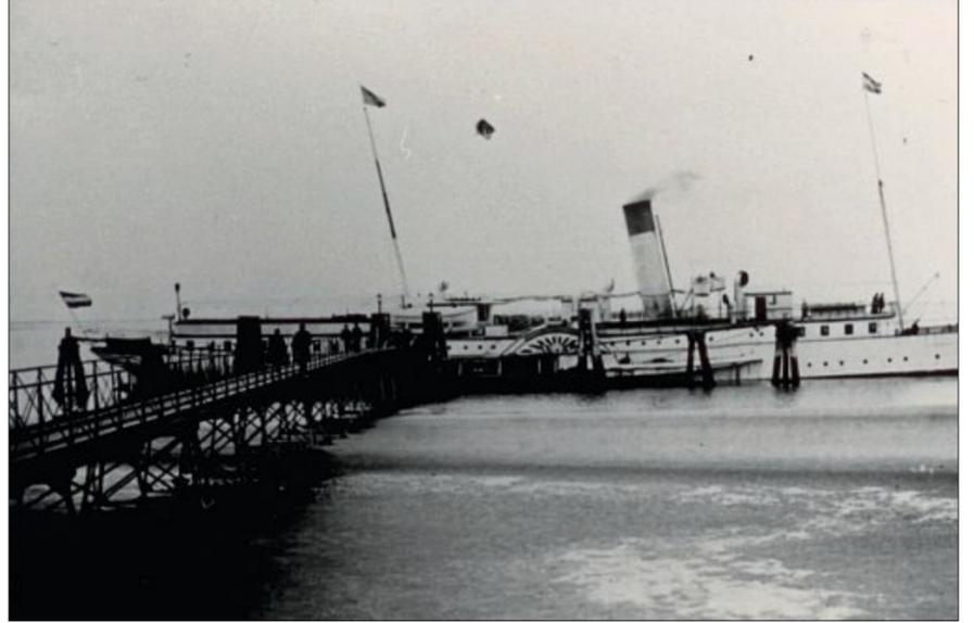
Diese Landungsbrücke wurde für die großen Dampfer des „Norddeutschen Lloyd“ gebaut. Diese hatten einen größeren Tiefgang als die üblichen Schiffe und fuhren die Route Helgoland – Bremerhaven. Der Zugang über den Steg zu den Schiffen erfolgte von der südlichen Seite der Wartehalle. Bei den Norderneyern hieß der Steg „Helgoland-Anleger“.
