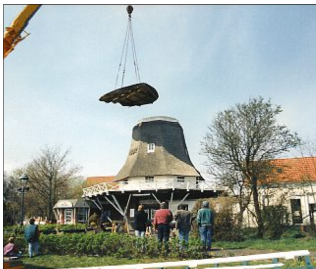
Die Mühle wird mit einer Platte abgedeckt für die Dauer der Kappen-Sanierung.
