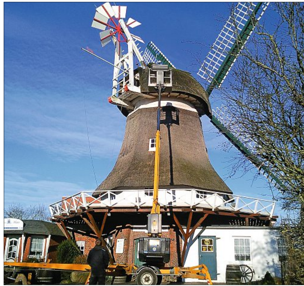
Ausbesserung des Reetdaches im November 2015.
