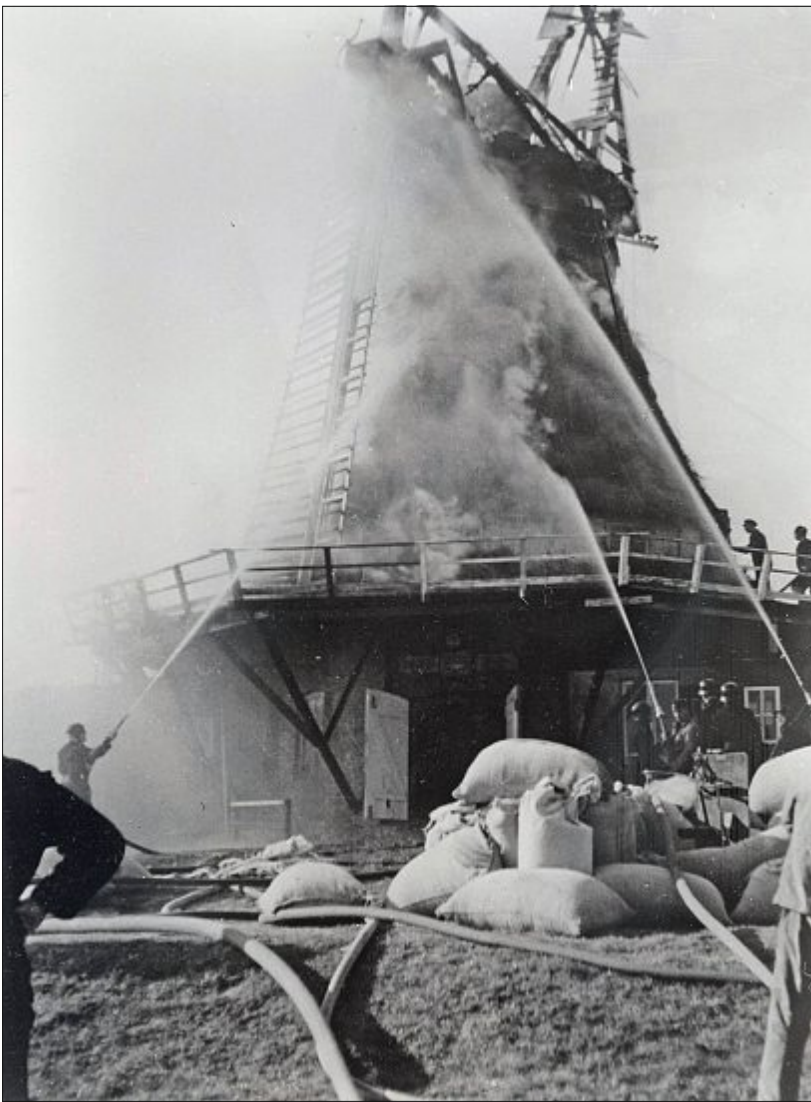
Großalarm am 24. April 1951: Die Inselmühle brennt. Die britische Militärfeuerwehr hilft der örtlichen Freiwilligen Feuerwehr bei den Löscharbeiten.
