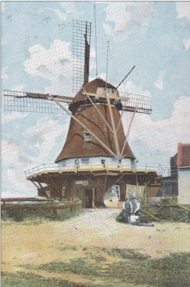
Die Norderneyer Mühle um 1900: Hier ist der Steert sehr gut zu erkennen, mit welchem die Mühle „in den Wind“ gedreht wurde. POSTKARTE AUS DEM STADTARCHIV
