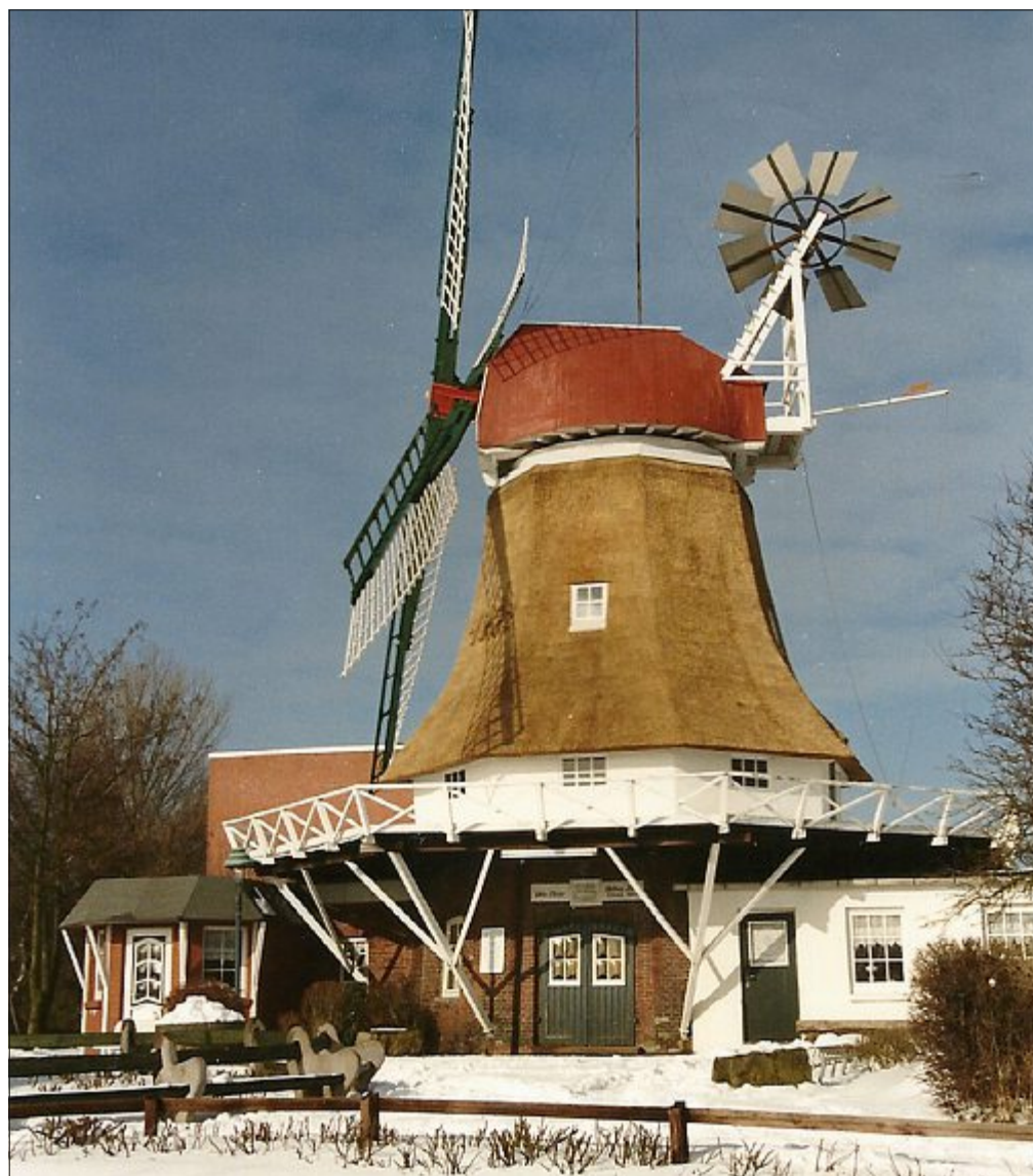
Dieses Foto ist eine Rarität: Der Rumpf ist bereits reetgedeckt, während die Kappe noch mit Dachpappe gedeckt ist.
