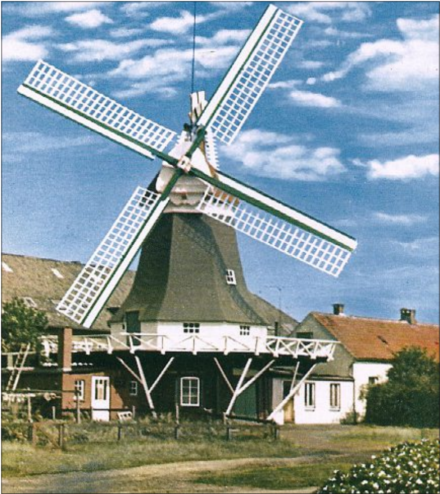
Die Mühle etwa Mitte der 1960er-Jahre. Der Achtkant und die Kappe sind mit grüner Dachpappe eingedeckt.
