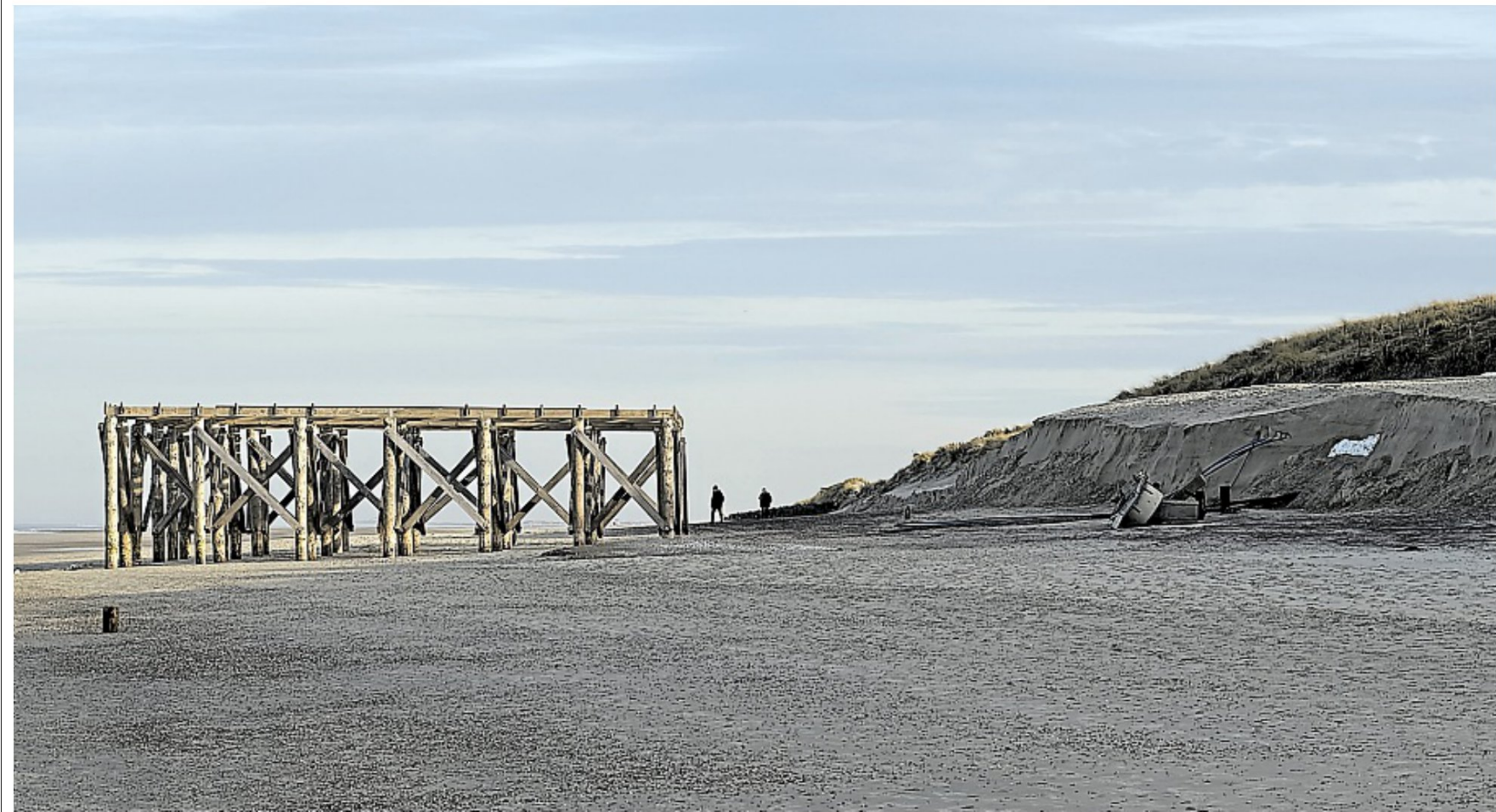
Auf diesem Bild vom vergangenen Herbst ist die mannshohe Abbruchkante gut zu erkennen.
